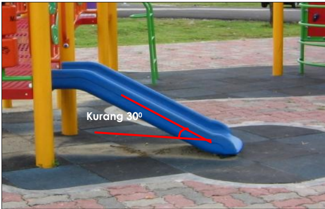
Foto 33 : Kecerunan papan gelongsur yang sesuai bagi kanak-kanak.
